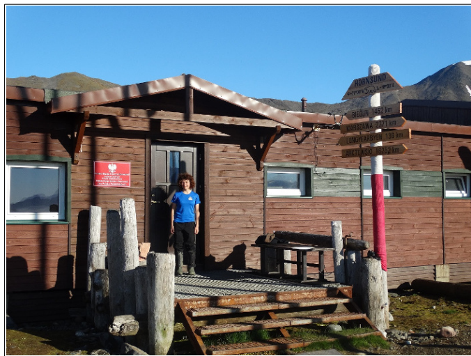
Budynek Stacji – adres Hornsund 1. Fot. Dominika Słowik.
